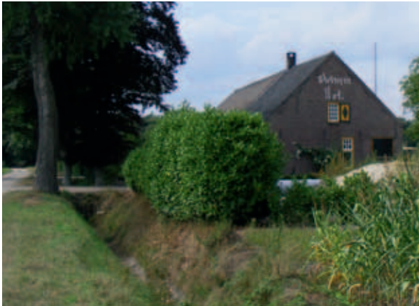
De huidige langgevelboerderij Wiebiegenhof werd in 1925 gebouwd in opdracht van Jan Boudewijns. (foto Hans Vogels)
